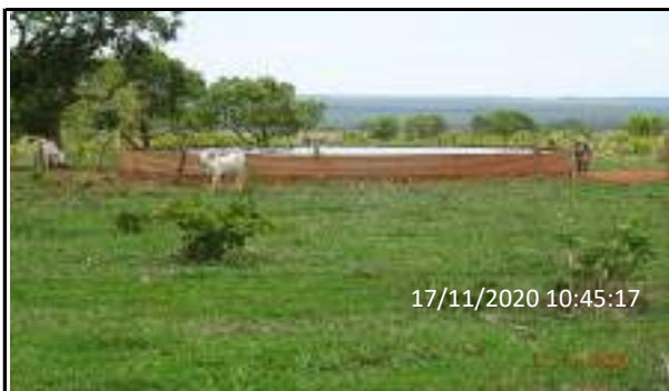
Reservatório de metálico
