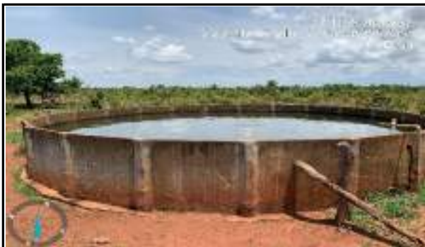
Reservatório de concreto
