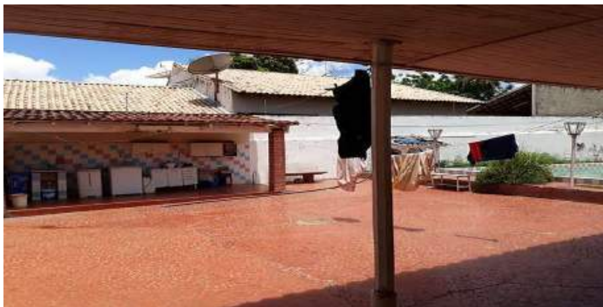
Área externa – fundos lavanderia
