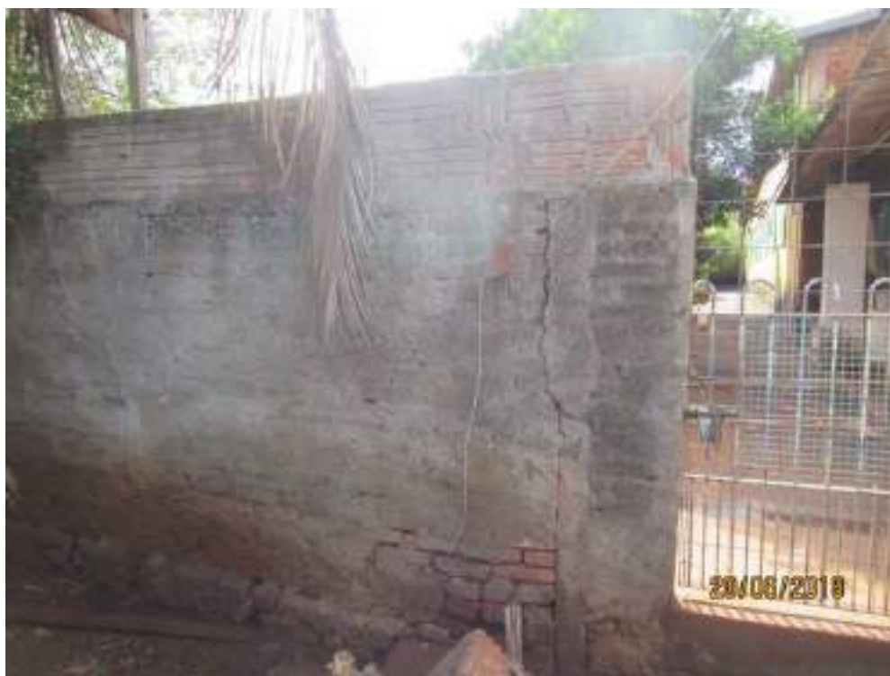
Imagem 19: Muro de divisa com o lote "ABE".
