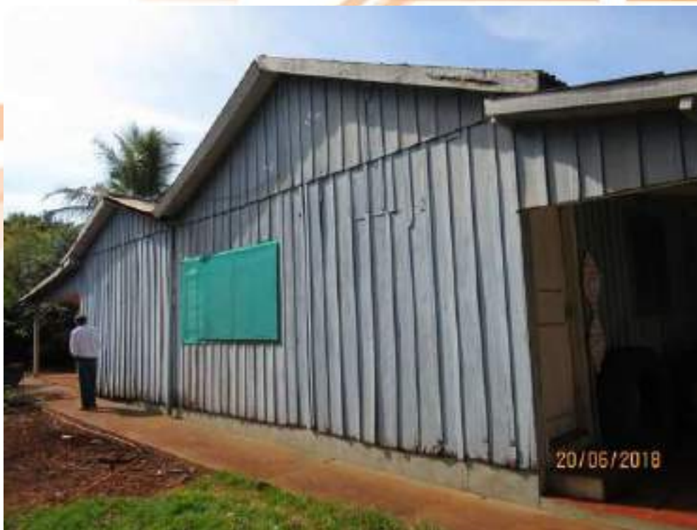
Imagem 08: Residência de madeira – Construção 01.
