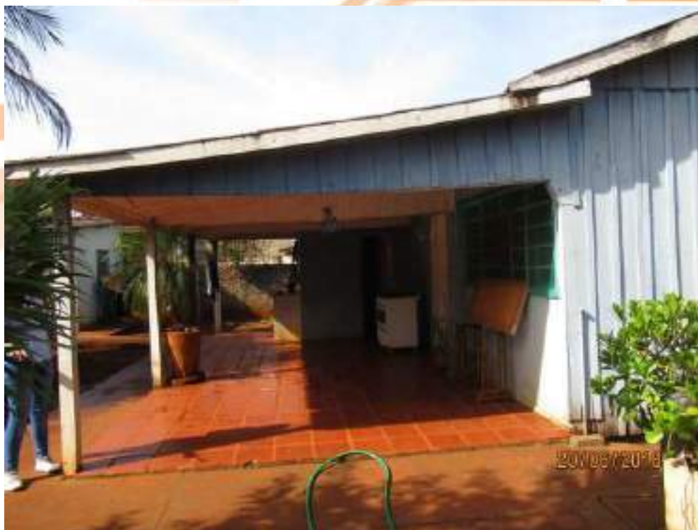
Imagem 10: Varanda 01 dos fundos.
