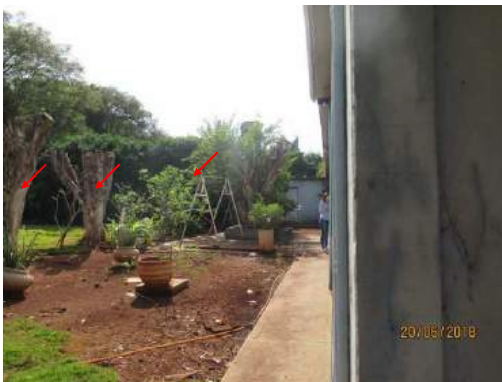
Imagem 09: Alinhamento de árvores na divisa com o lote "I" – Construção 01.
