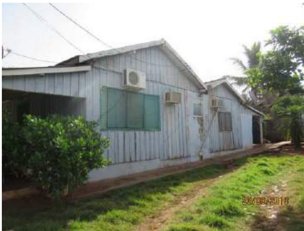
Imagem 11: Residência de madeira – Construção 01.
